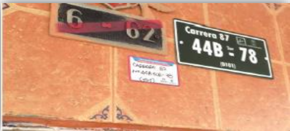
Imagen 21. Instalación Placas Domiciliarias
